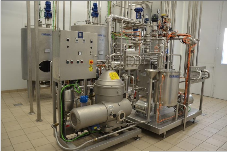
Intercambiador de placas
